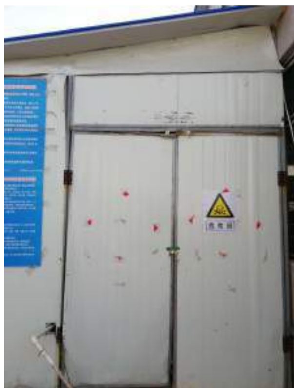
危险废物暂存间及标识
