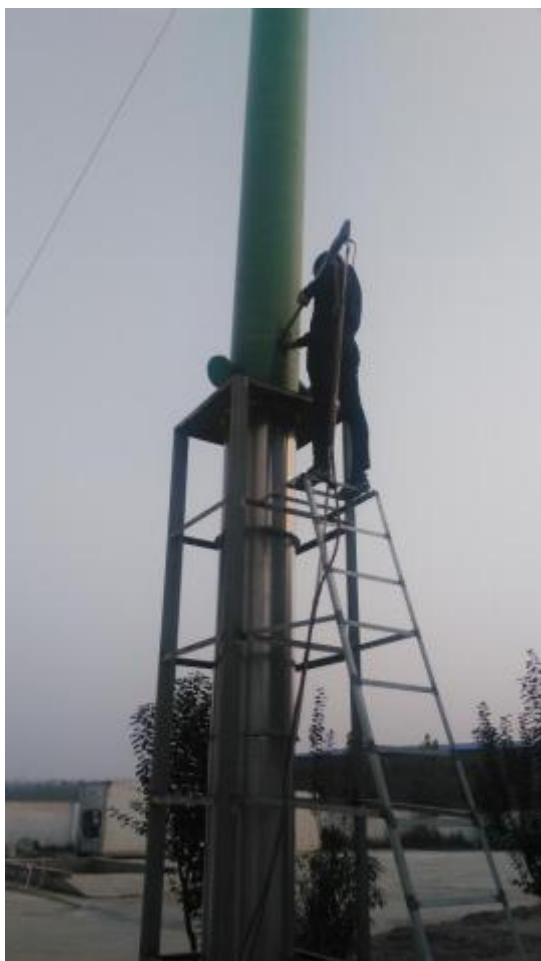
车间废气排气筒采样
